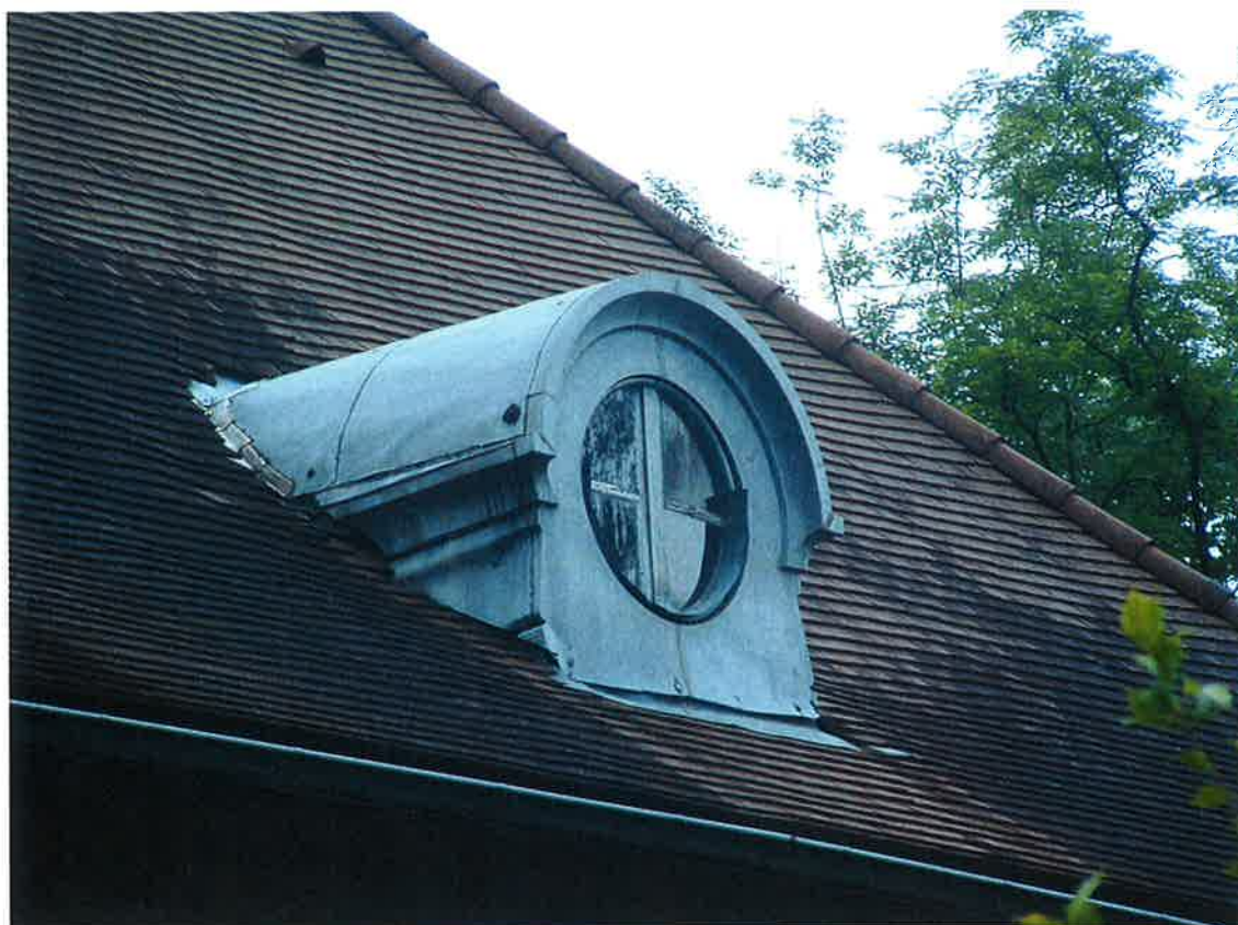
1.b : Vue extérieure
