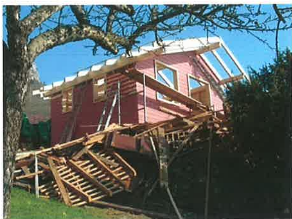
Remplacement de la charpente : les anciens éléments ont été enlevés, les neufs mis en place
