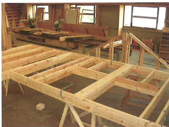
La fabrication des panneaux en atelier
