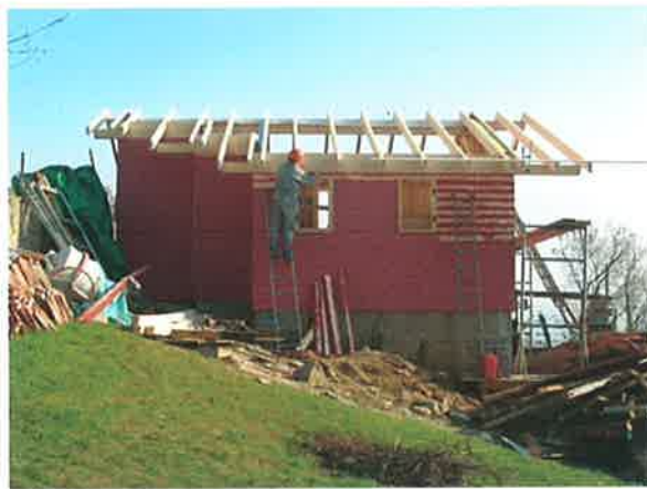
Le client est en train de passer la 2 e couche de peinture...
