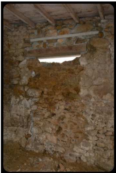
pendant les travaux
